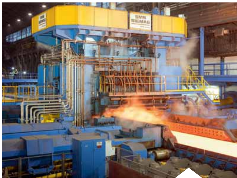
Для охлаждения нового прокатного стана на NLMK DanSteel требуется исключительно чистая подпиточная вода
